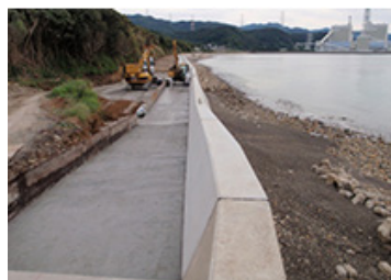
護岸ブロック背面裏込め
