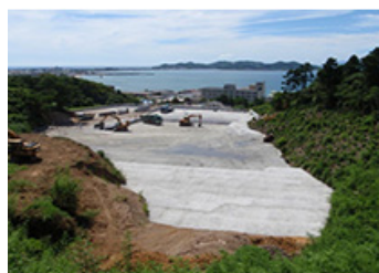
宅地造成盛土への適用事例
